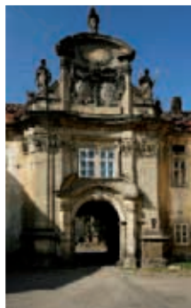
Vstup do areálu kláštera
